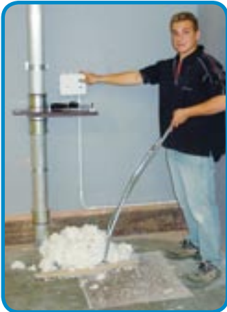
V-süpürücüsü kullanarak zemin atıklarının toplama noktasında toplanması
